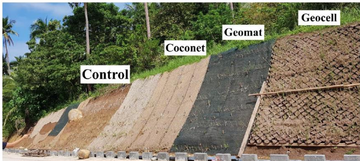
شکل ۴- تصویر کاربرد ژئوتکستایل ها در سایت پروژه با پوشش گیاهی
