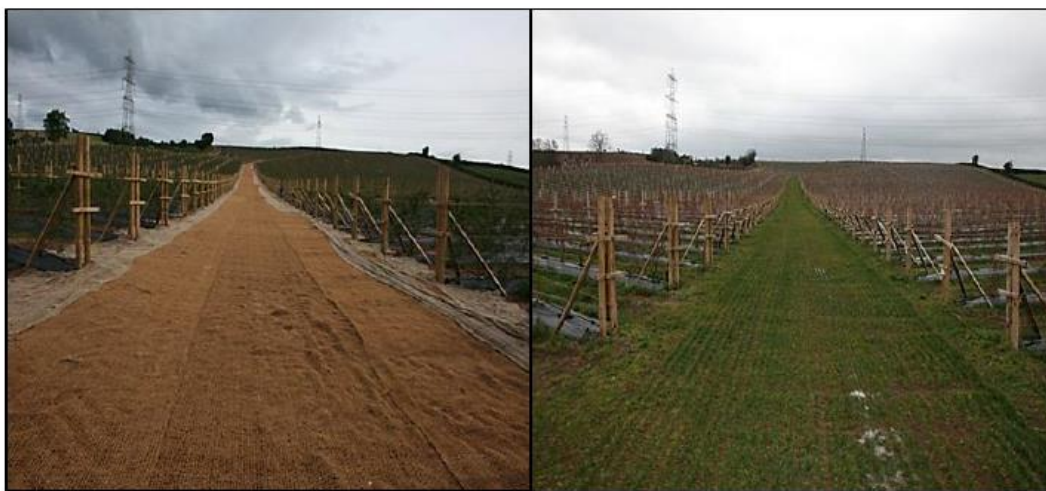
شکل ۳- geotextile نصب شده قبل از (سمت چپ) و پس از (راست) رشد پوشش گیاهی. (Rickson, 2013).
