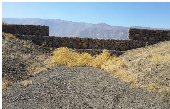
شکل ۱. نمایی از یک بند سنگی‌توری واقع در حوزه آبخیز رزین
