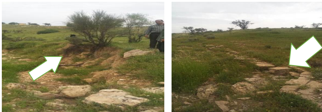
شکل ۵- سیل بند سنتی به شکل پله منقطع در منطقه (سمت راست) و سنگچین‌های ترمیم نشده (سمت چپ)
